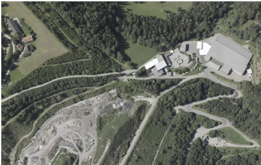
Die Flugroboter erfassen großflächige unwegsame Standorte lückenlos. Durch die geringe Flughöhe wird eine bis auf drei Zentimeter exakte Flächen- und Höhenvermessung erreicht.
